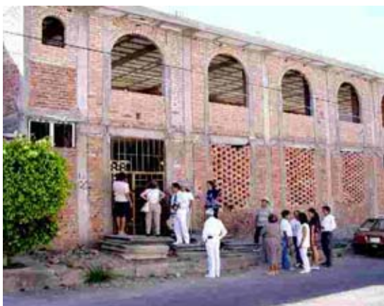
Casa Sede, (en construcción) Tepic, Nayarit, Méx.
