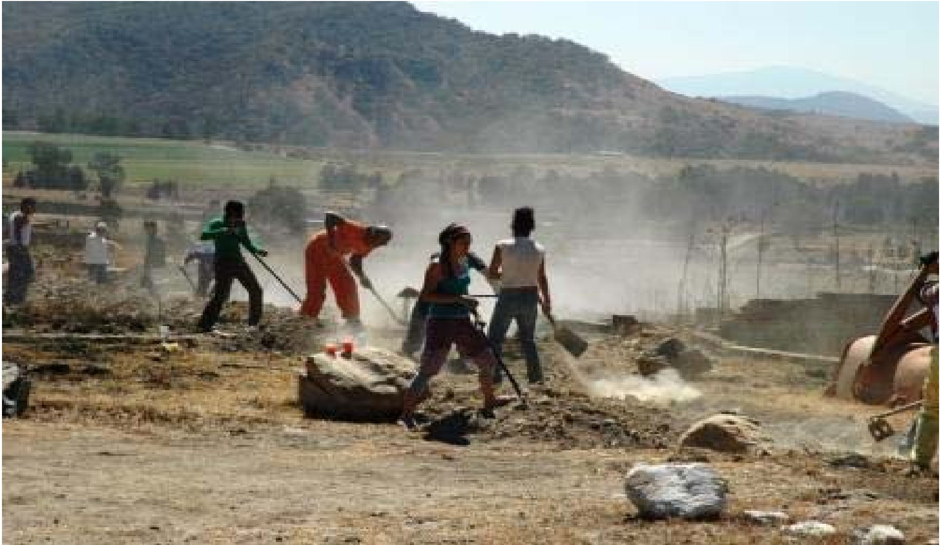
Construcción del Salón de usos múltiples por la Hermandad del Occidente de México.
